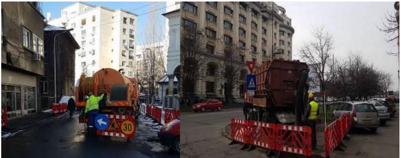
Curatare conducte canalizare
