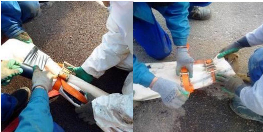
Pregatire tragere tub pe conducta
