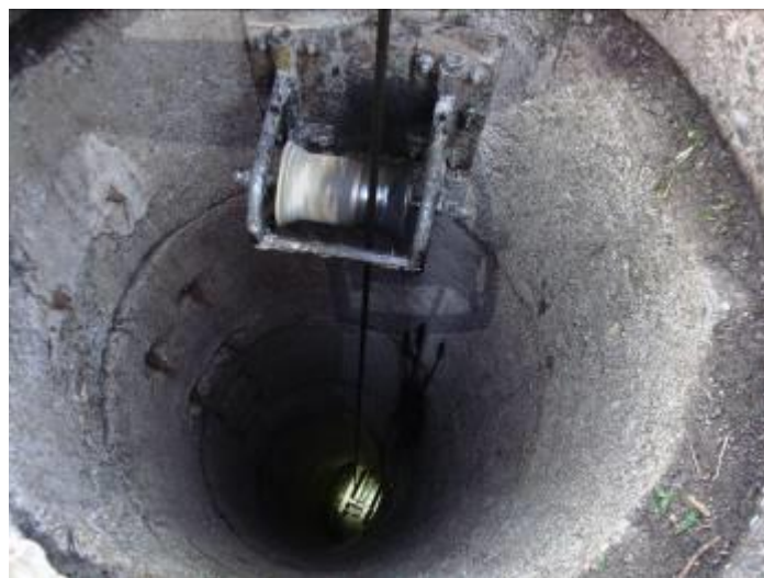
Trager liner cu troliu tractiune (scripeti cu role)
