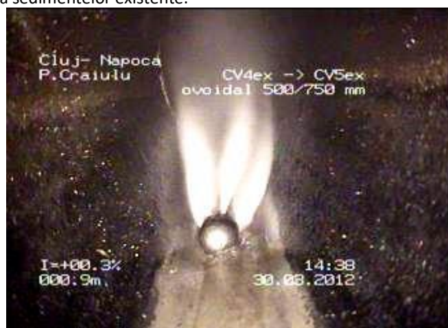
Duza de curățare hidrojet pe conductă de canalizare ovoid DN 500/750
