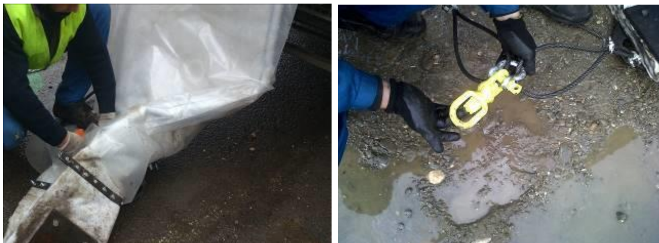
Legare liner de sufa de tractiune trolu
