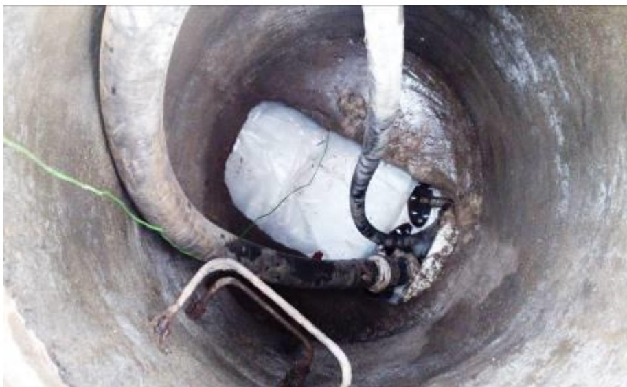
Material de camasiuire conectat la abur
