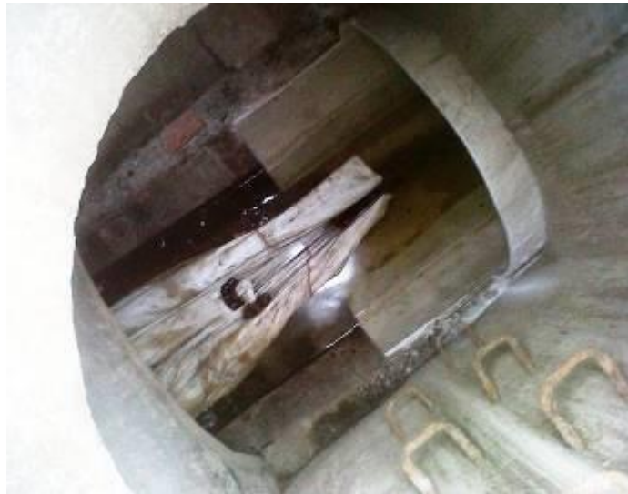
Trager liner pe conducta de reabilitat prin metoda "pull in"
