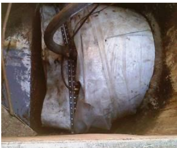
Liner mufat si umflat pentru polimerizare
