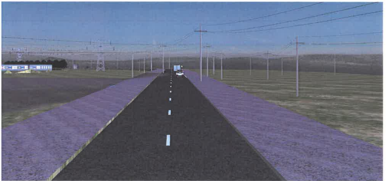
Figura 5.1.5 PC11+00.00 Stâlpii va fi reamplasați
