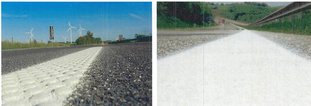
Fig.3 Detaliu marcaje rutiere realizate cu Produs bicomponent PlastiRoute™
