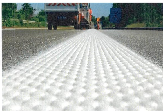
Fig.1 Marcaje rutiere realizate cu produse PlastiRoute® bicomponent
