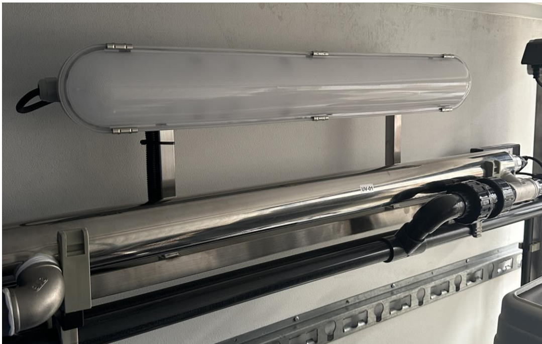
Ультрафиолетовая лампа UV-01.
