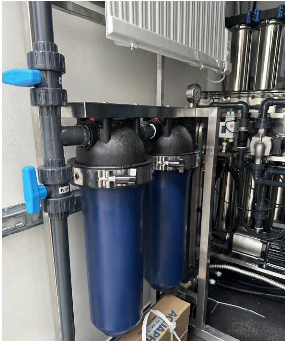
Полипропиленовый и угольный фильтры в корпусах VikingPro
