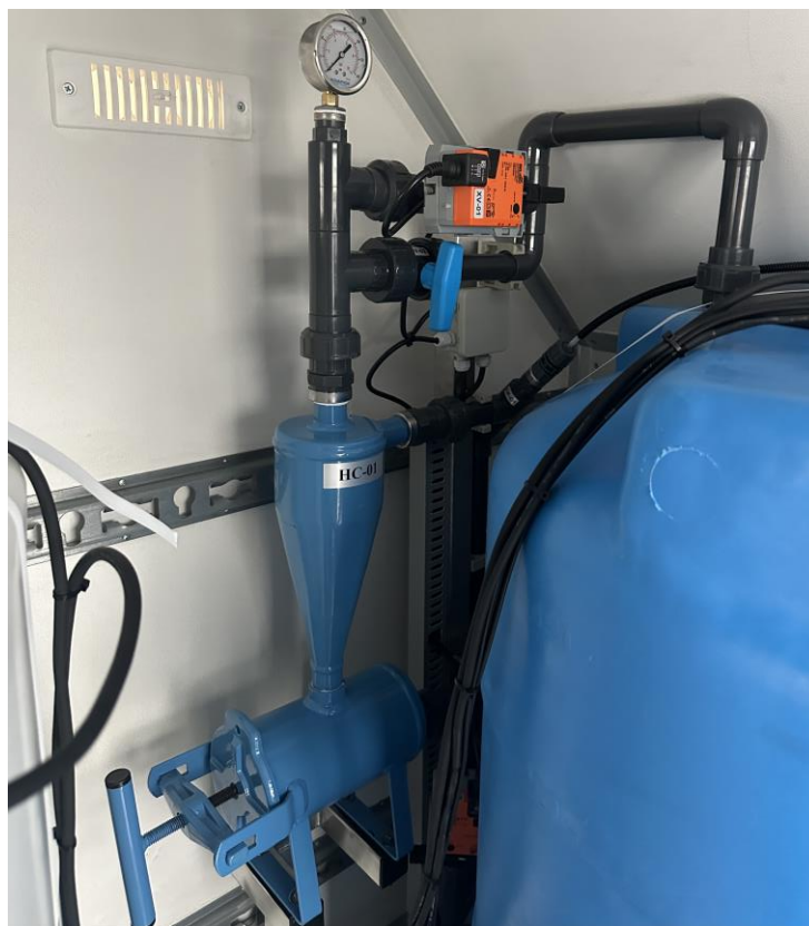
Клапан XV-01 и Гидроциклон HC-01
