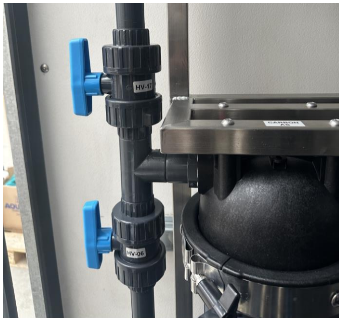
Кран HV-17 и HV-15 в положении подачи воды потребителю.
