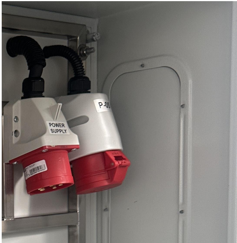
Подключение силового кабеля 380 В и погружного насоса P-05
