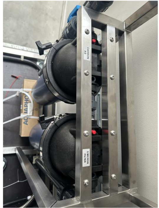
Полипропиленовый и угольный фильтры в корпусах VikingPro
