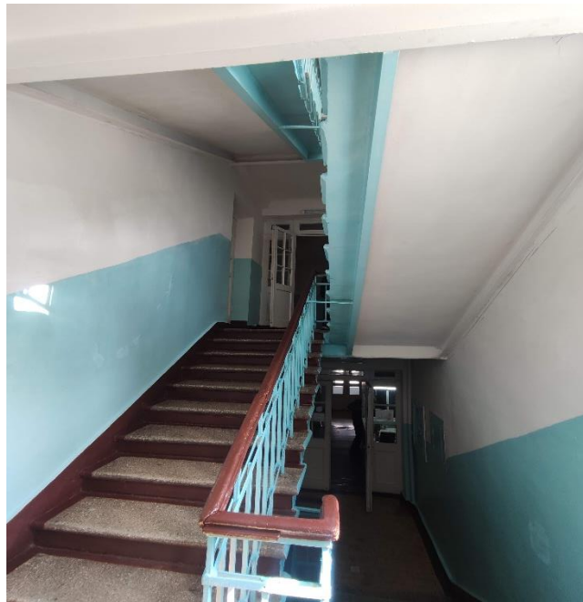
Fig. 8. Aspectul casei scării a clădirii căminului nr.4 examinate.
