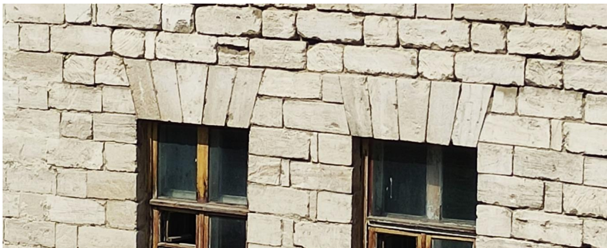
Fig. 7. Aspectul buiandrugilor peste golurile ferestrelor.
