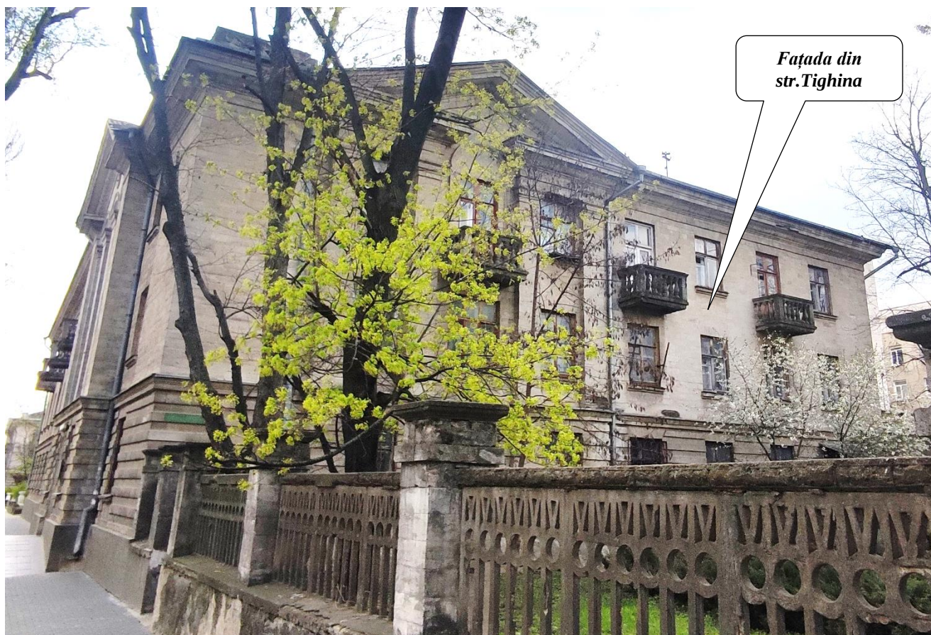
Fig. 4. Aspectul exterior clădirii căminului nr.4 examinate
