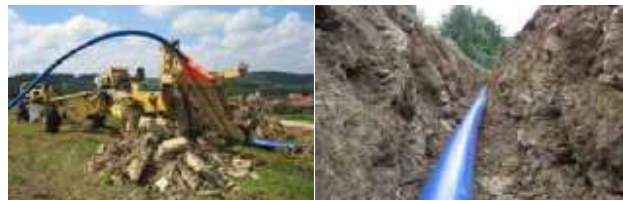
așezare fără săpatul șanțului deschis metoda așezării prin arat
