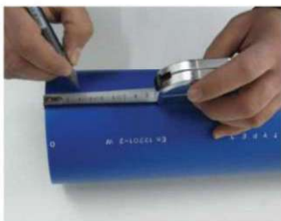
Măsurați și marcați țeava
