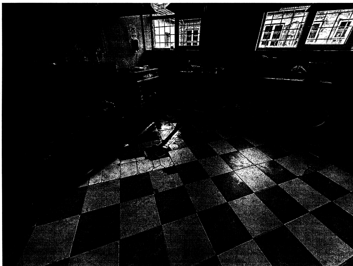
ФОТО 12. В ПОМЕЩЕНИЯХ С МОКРЫМИ ПРОЦЕССАМИ ПОДОВАЯ ПЛИТКА ТРЕБУЕТ ЗАМЕНЫ
