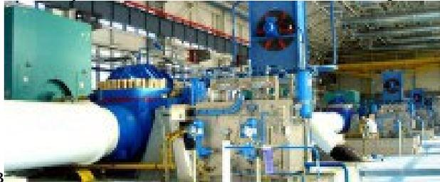
электронасосных агрегатов НМ 10 000-380-2 с частотно регулируемым приводом, специально созданных для нефтепровода ВСТО-1Р (Восточная Сибирь – Тихий океан, расширение первой очереди).
