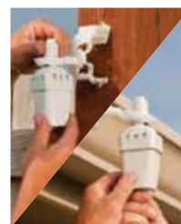
Установить датчик, воспользовавшись монтажным кронштейном.
