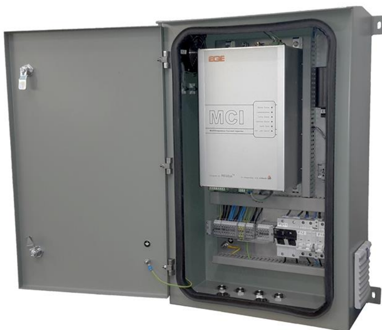
Рис. 7: MCI P-01 в отдельном шкафу для последующей установки на реактор.
