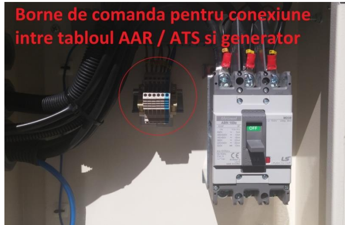
Borne comanda amplasate in interiorul grupului electrogen – zona panoului de comanda
