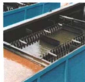
Transferul de apa intre zona de coagulare/floculare si cea de sedimentare se face printr-o camera de liniștire amplasata sub modulul lamelar. Placile inclinate, ce formeaza modulul lamelar cu celule patrate, ajuta sedimentarea si face posibila reducerea zonei de suprafața a structurii.
