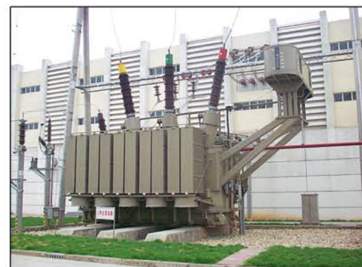
在湖北宜昌运行的220kV油浸式电力变压器 220kV Oil-immersed Power Transformer is operating in Yichang, Hubei province
