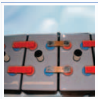
Рис. 5 Медные жесткие соединители под пайку
