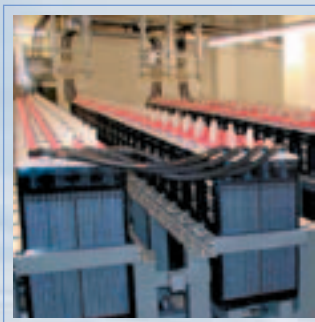
Рис. 17 Смонтированная батарея Classic OCSM
