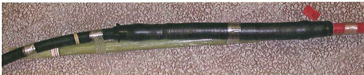
Fot.1. Widok muf przelotowych typu EPJMe-1C-24-F [ po montażu ].
