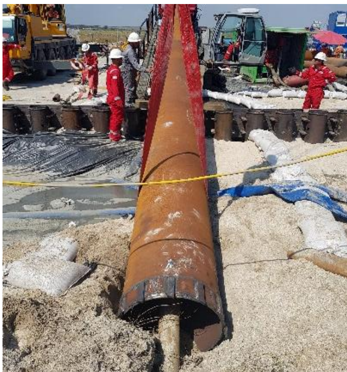
Instalare tub protector de început
