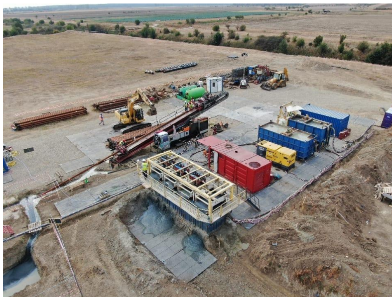
Exemplu platforma intrare foraj
