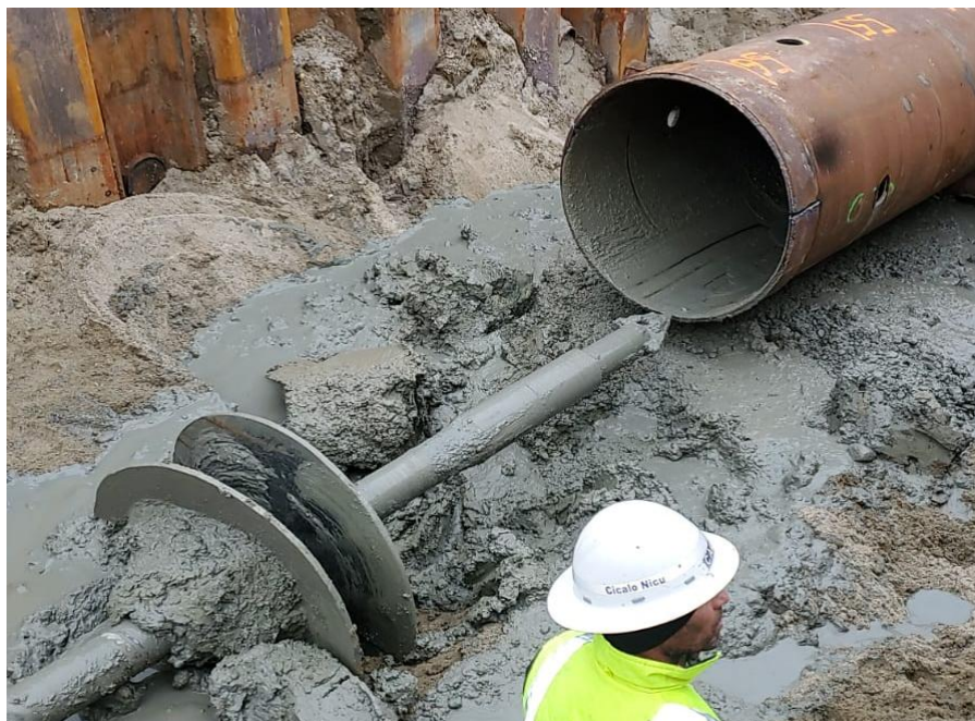
Exemplu curatare tub protector cu snec / melc ( sol pietris / bolovanis )
