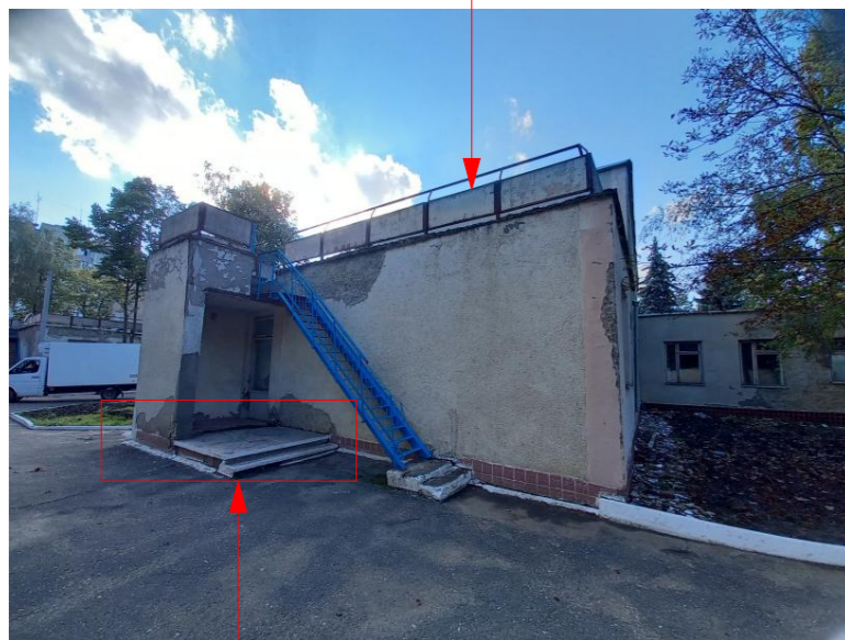
Scările din beton existente distruse se demontează, va fi construite noi
