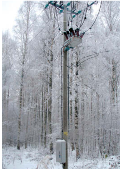
ВАКУУМНЫЙ РЕКЛОУЗЕР OSM И ШКАФ УПРАВЛЕНИЯ RC
