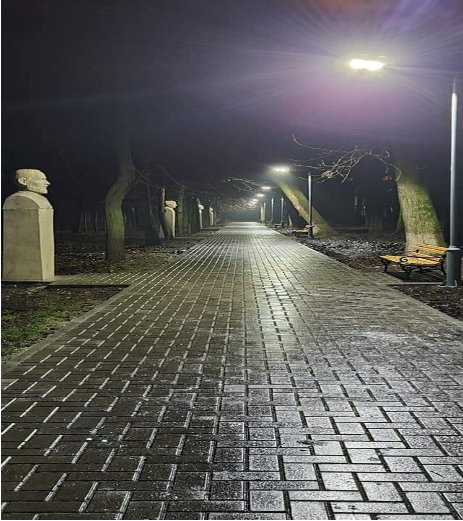
Parcul Glodeni (Pavarea aleilor si iluminatul stradal)-2020
